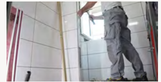
Tag 5,6 und 7: Aufbau des Blome Bades inklusive Blome Badwände, Installation der Vorwände und Verrohrung
