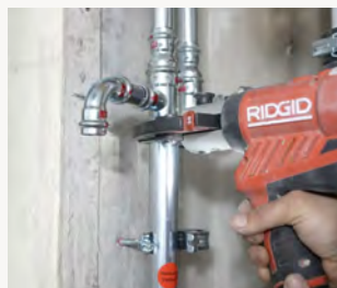
Tag 2: Installation des neuen Versorgungsstrangs
