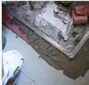
Tag 3: Montage der ebenerdigen Dusche
