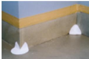
2. Triflex Spezialvlies-Zuschnitte für Innen- und Außenecken erstellen: Kreisförmiger Zuschnitt (ca. Ø 10 cm) mit einem Einschnitt bis zur Mitte.
