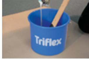
3. Gegebenenfalls Teilmenge entnehmen. Der Teilmenge entsprechenden Anteil an Triflex Katalysator klumpenfrei einrühren. Rührzeit mindestens 2 Min.
