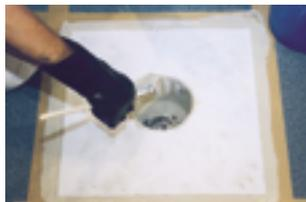
6. Das Vlies für die Fläche blasenfrei einlegen und die sternförmigen Einschnitte mit dem Pinsel in den Gully umlegen.
