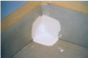
5. Innenecke: Abdichtungsharz satt mit einem Pinsel oder einer Heizkörperrolle vorlegen und die zugeschnittene Innenecke blasenfrei einlegen.
