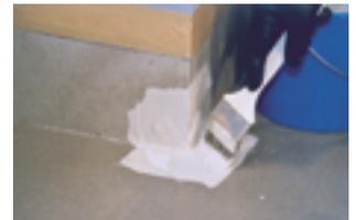
4. Anschließend die eingelegte Außenecke nochmals mit einer Lage Abdichtungsharz satt abdecken.
