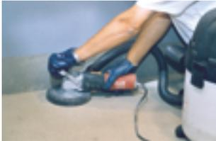
1. Saugende Untergründe (z.B. Beton, Asphalt) müssen mit einem Beton-Diamant-Schleifer geschliffen werden, um einen haft- und tragfähigen Untergrund zu erhalten.
