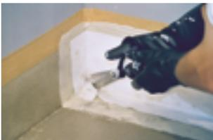
9. Bei Innenecken wird das Vlies 5 cm um die Ecke geführt und die Falte im Bodenbereich schräg bis zur Ecke eingeschnitten. Anschließend wird der Einschnitt überlappt, wobei darauf zu achten ist, dass sich keine trockenen Vliesstücke überlappen.
