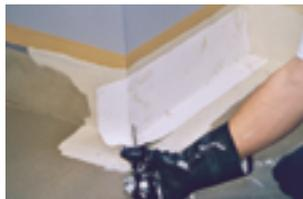
10. Bei Außenecken wird das Vlies 5 cm bis über die Ecke geführt und im Bodenbereich nochmals mit einer Lage Abdichtungsharz satt abdecken. Anschließend wird der Einschnitt um die Ecke gelegt und der freie Bodenbereich wird mit einem zusätzlichen Vlieszuschnitt abgedeckt.
