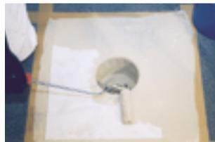
7. Anschließend das Vlies satt von oben mit Harz (ca. 1,00 kg/m<sup>2</sup>) abdecken. Das Putztuch aus dem Gully entfernen und das Klebeband im noch frischen Zustand abziehen.
