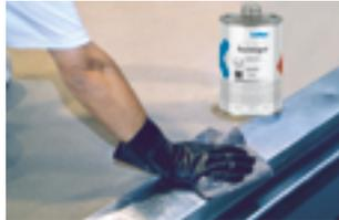
2. Metalle oder PVC werden vor dem Beschichten der Oberfläche mit Triflex Reiniger entfettet und anschließend angeraut.
