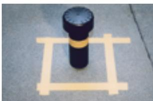
1. Lüfter in Abdichtungshöhe und Fläche in Abdichtungsweite (min. 10 cm) abkleben. Triflex Spezialvlies-Zuschnitte erstellen. Rohr: Breite: 20 cm, Länge: Rohrumfang + 5 cm. Das Vlies wird über die ganze Länge 5 cm tief und 1 cm breit streifenförmig eingeschnitten.
