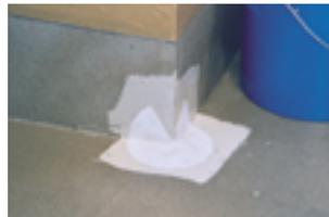
3. Außenecke: Abdichtungsharz satt mit einem Pinsel oder einer Heizkörperrolle vorlegen und die zugeschnittene Außenecke blasenfrei einlegen.
