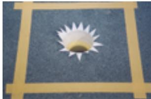
2. Triflex Spezialvlies-Zuschnitte erstellen. Gully: Breite: 15 cm, Länge: Gullyumfang + 5 cm. Das Vlies wird über die ganze Länge 5 cm tief und 1 cm breit sternförmig eingeschnitten.
