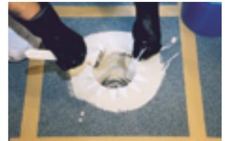
4. Abdichtungsharz in und um den Gully satt vorlegen (ca. 2,00 kg/m<sup>2</sup>) und den Zuschnitt für den Gully blasenfrei einlegen. Die sternförmigen Einschnitte auf die Fläche umlegen und das Vlies nochmals satt von oben (ca. 1,00 kg/m<sup>2</sup>) abdecken.
