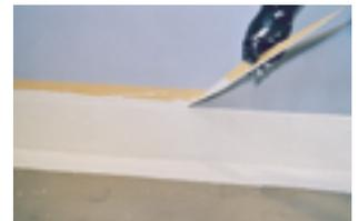
12. Das Klebeband im noch frischen Zustand entfernen.
