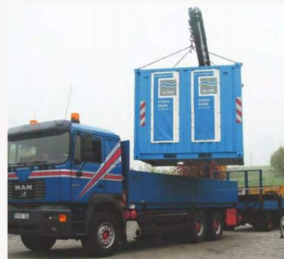
4. Die fertigen BadWände werden in Container verladen und mit allen weiteren Bestandteilen zum Einbauort geliefert.
