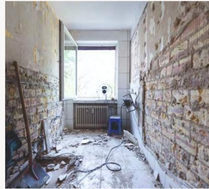
5. Das alte Bad wird demontiert und entsorgt. Die vorhandenen Fliesen können, müssen aber nicht entfernt werden.
